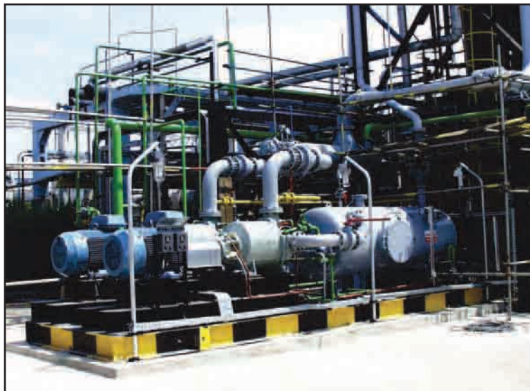
Sistema de vácuo duplex usado em torre de destilação de petróleo bruto
